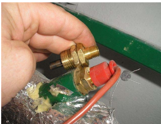
Foto R Párované teploměry - jeden osazen na lokalitě a druhý osazen výrobcem měřidla.
