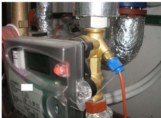
Foto R Párované teploměry - jeden osazen na lokalitě a druhý osazen výrobcem měřidla.
