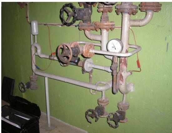
Foto R Párované teploměry - jeden osazen na lokalitě a druhý osazen výrobcem měřidla.
