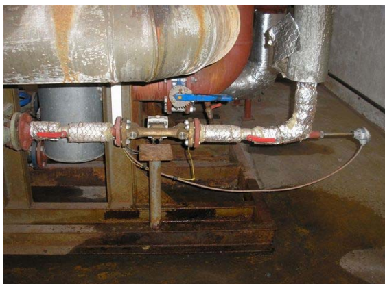
Foto K Potrubí v místě montáže teploměru není izolováno nebo je izolace nedostatečná.
