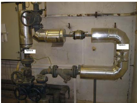
Foto K Potrubí v místě montáže teploměru není izolováno nebo je izolace nedostatečná.
