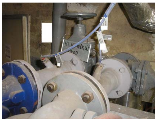
Foto K Potrubí v místě montáže teploměru není izolováno nebo je izolace nedostatečná.
