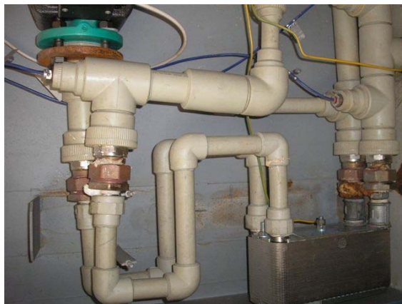
Foto R Párované teploměry - jeden osazen na lokalitě a druhý osazen výrobcem měřidla.
